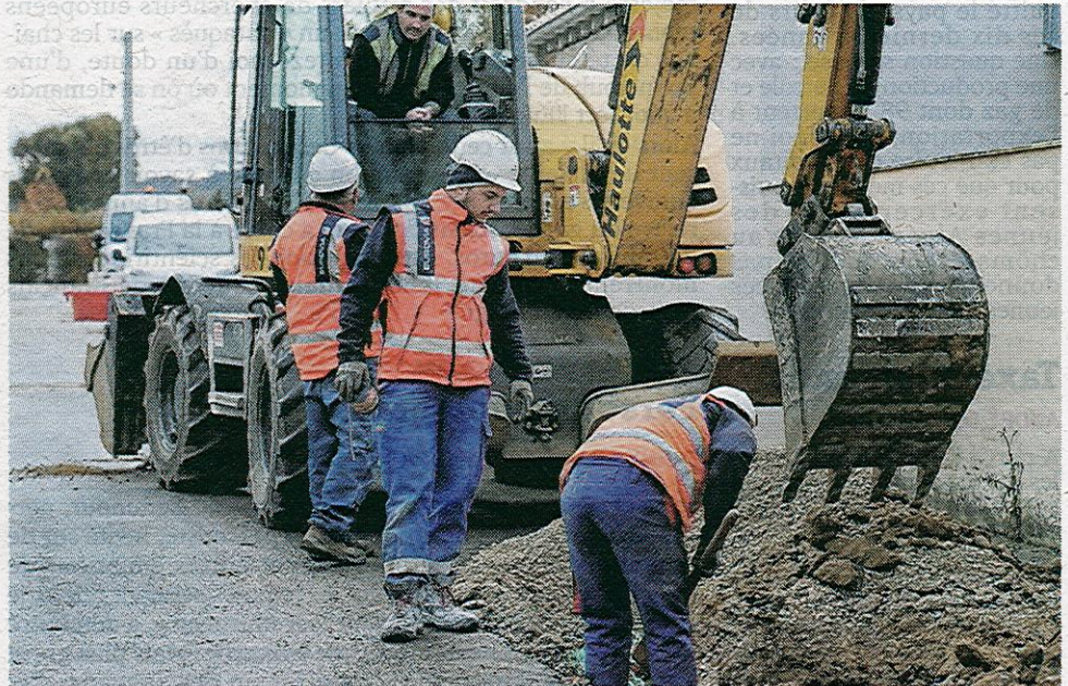
■ Travaux de voirie à Péronnas. D'autres communes préfèrent attendre avant d'engager des travaux. Photo Laurent Thevenot
